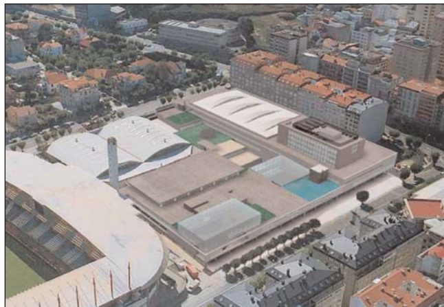
Imagen aérea de la Casa del Agua. Abajo, recorrido de la canalización de agua salada que abastece la zona de talasoterapia del complejo
